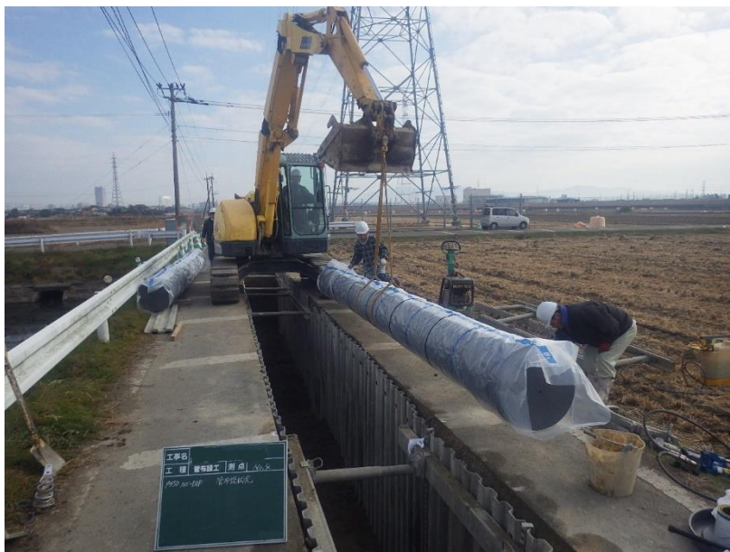
耐震管を布設する様子
