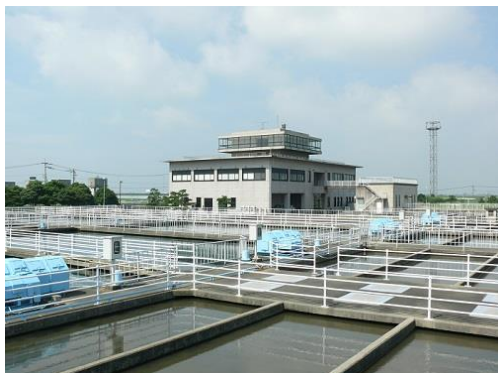
北茂安浄水場
