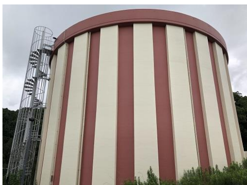
白壁中継ポンプ場
