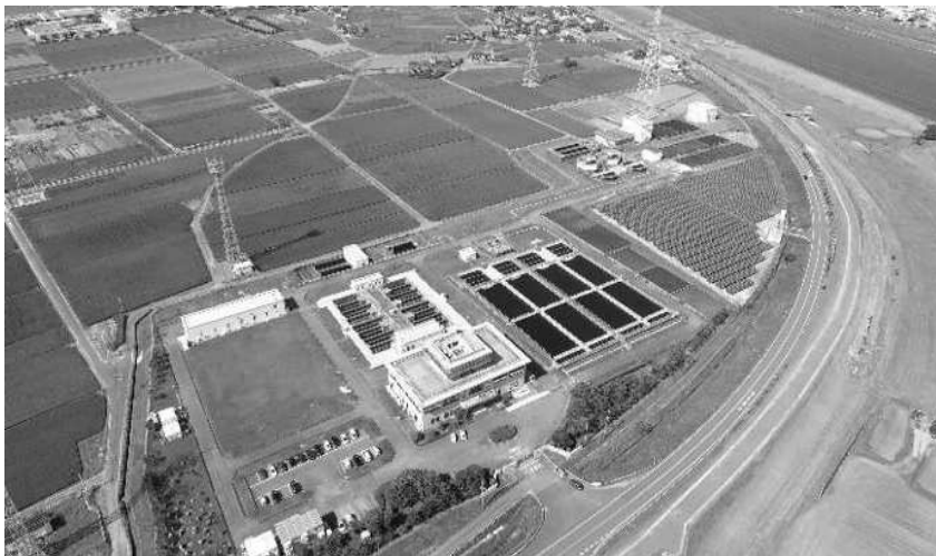
— 北茂安浄水場（三養基郡みやき町） —
